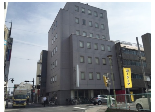
岡山駅前にある KLab 岡山事業所オフィスビル
