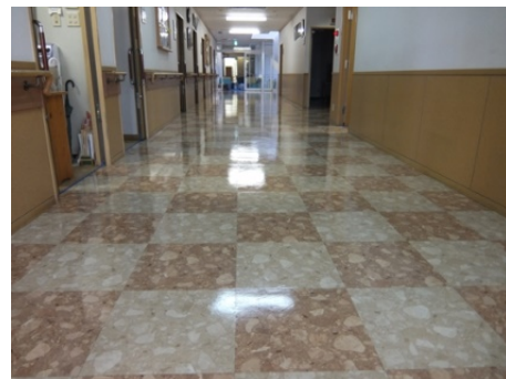
ファインコート施工後の外来廊下エリア
