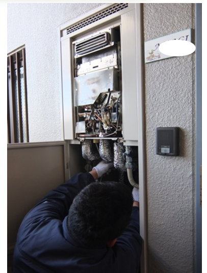
ガス給湯器の入替工事
