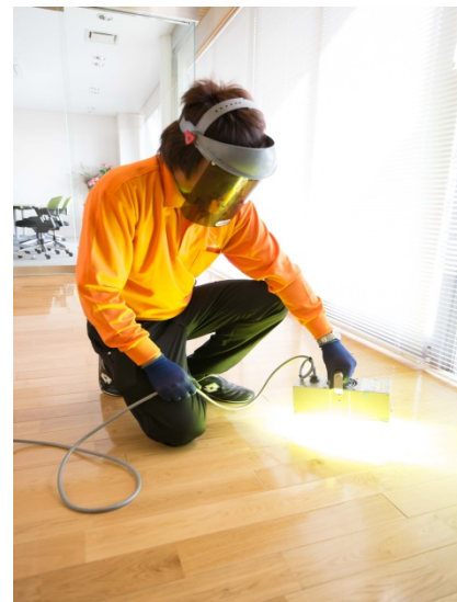
「ウイナップ」施工風景 紫外線を照射する特殊な技術
