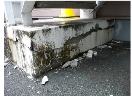
次の「揺れ」に備えた修繕が急務です
