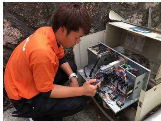
貯水槽の圧力ポンプの基盤を点検中
