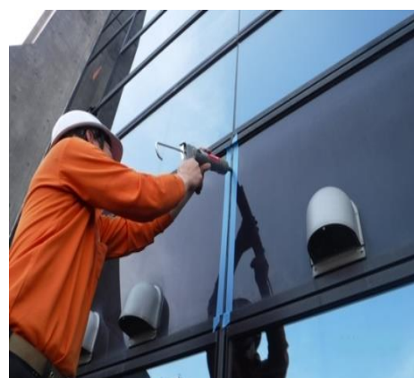
《ガラス枠のコーキング作業》
