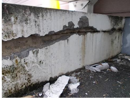
階段下の基礎にも大きな亀裂があります
