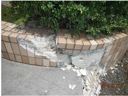
破損したアパートのエントランス部分
