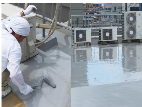
《屋上防水塗装》
