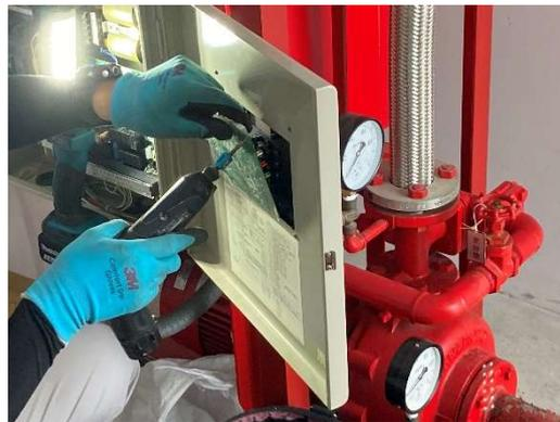
消火ポンプ制御盤基板交換工事
