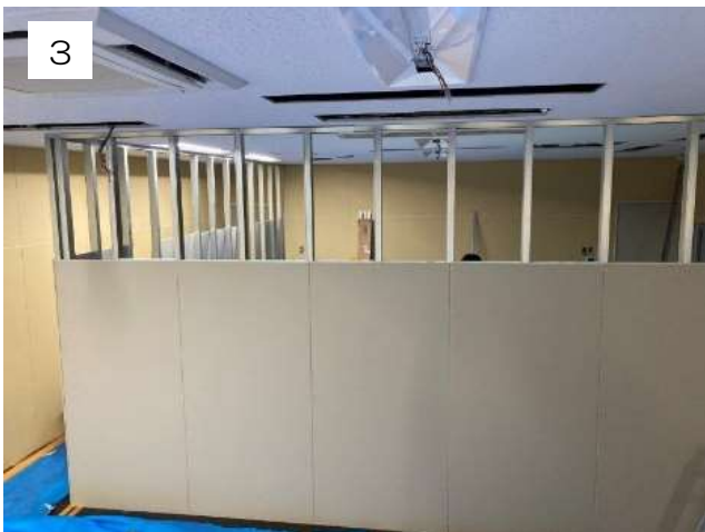
3 防音材を石膏ボードで囲っていきます。
