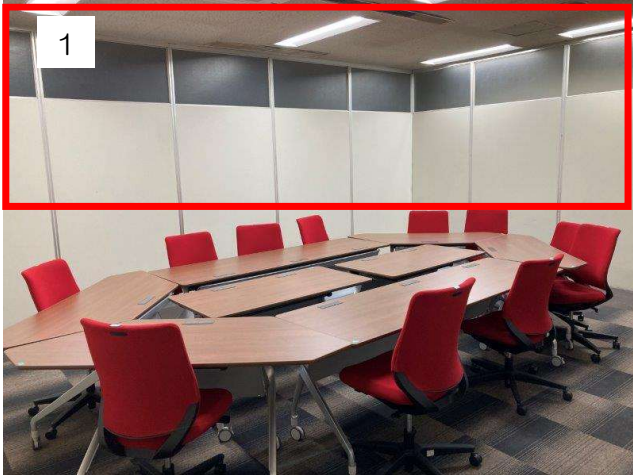
1 パーティションで区切っている会議室。 今回はこの 赤枠部分 をLGS造作壁へ変更します。
