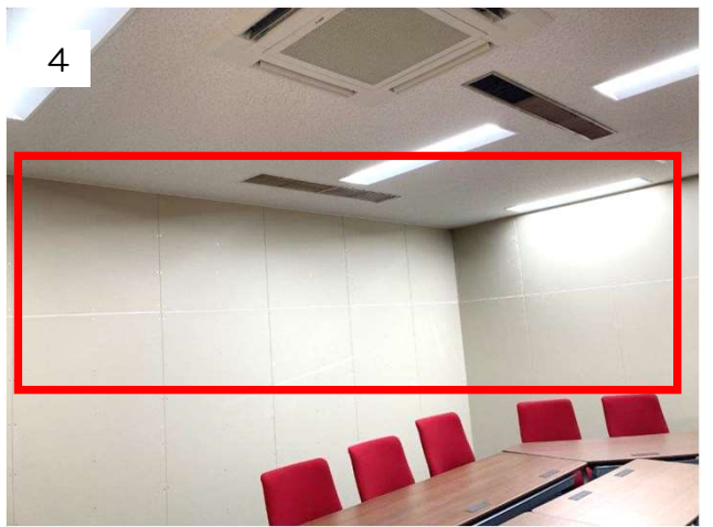
4 赤枠部分 をLGS造作壁へ変更が完了しました！
