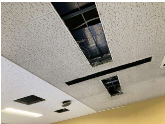
↑天井の張り増し作業も行いました。
