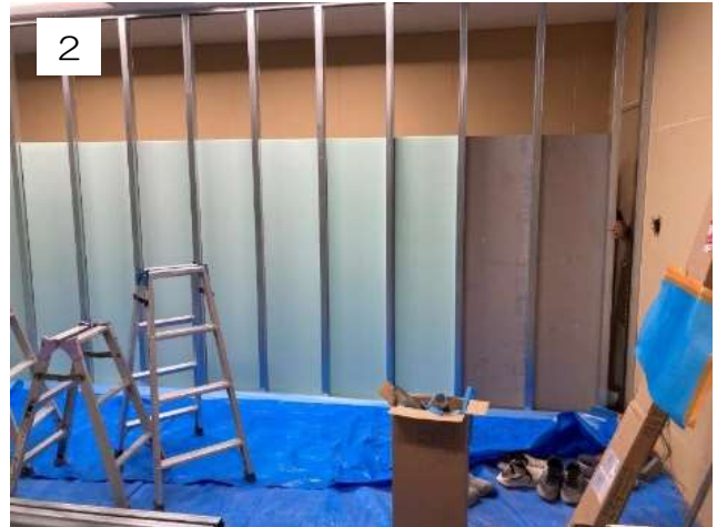
2 パーティションを取り外し、軽量形鋼で下地を組み、 防音材を取り付けていきます。
