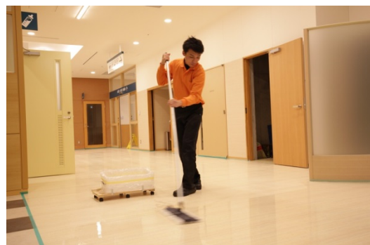
ファインコート塗布作業の様子
